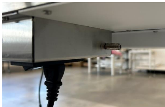
11.1 pav. Dujų įvadas po viengubu stalviršiu
